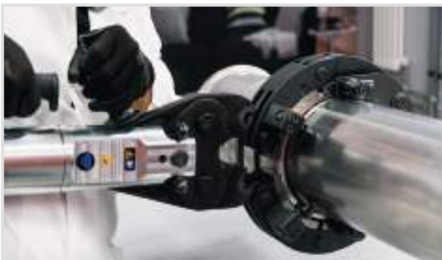
Assemblaggio pressatura n°1 / Press assembly phase 1
